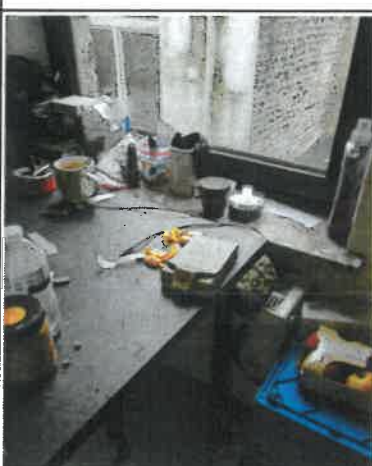
Foto 17: 233: ontbrekende of onvoldoende hoge/stevige borstwering bij lage ramen (vanaf eerste verdieping)
