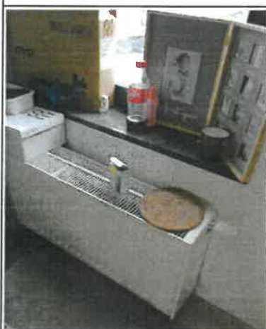
Foto 16: 233: ontbrekende of onvoldoende hoge/stevige borstwering bij lage ramen (vanaf eerste verdieping)
