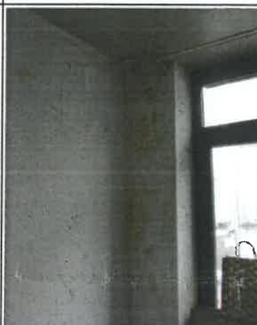
Foto 9: 111: opstijgend vocht / doorslaand vocht
